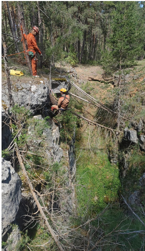
Labores de instalación en una sima con una amplia boca de entrada
